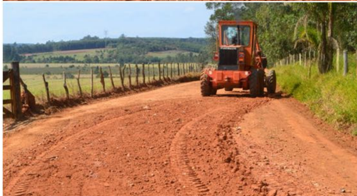
Recuperação de acesso do Bairro Ferreira das Almas
