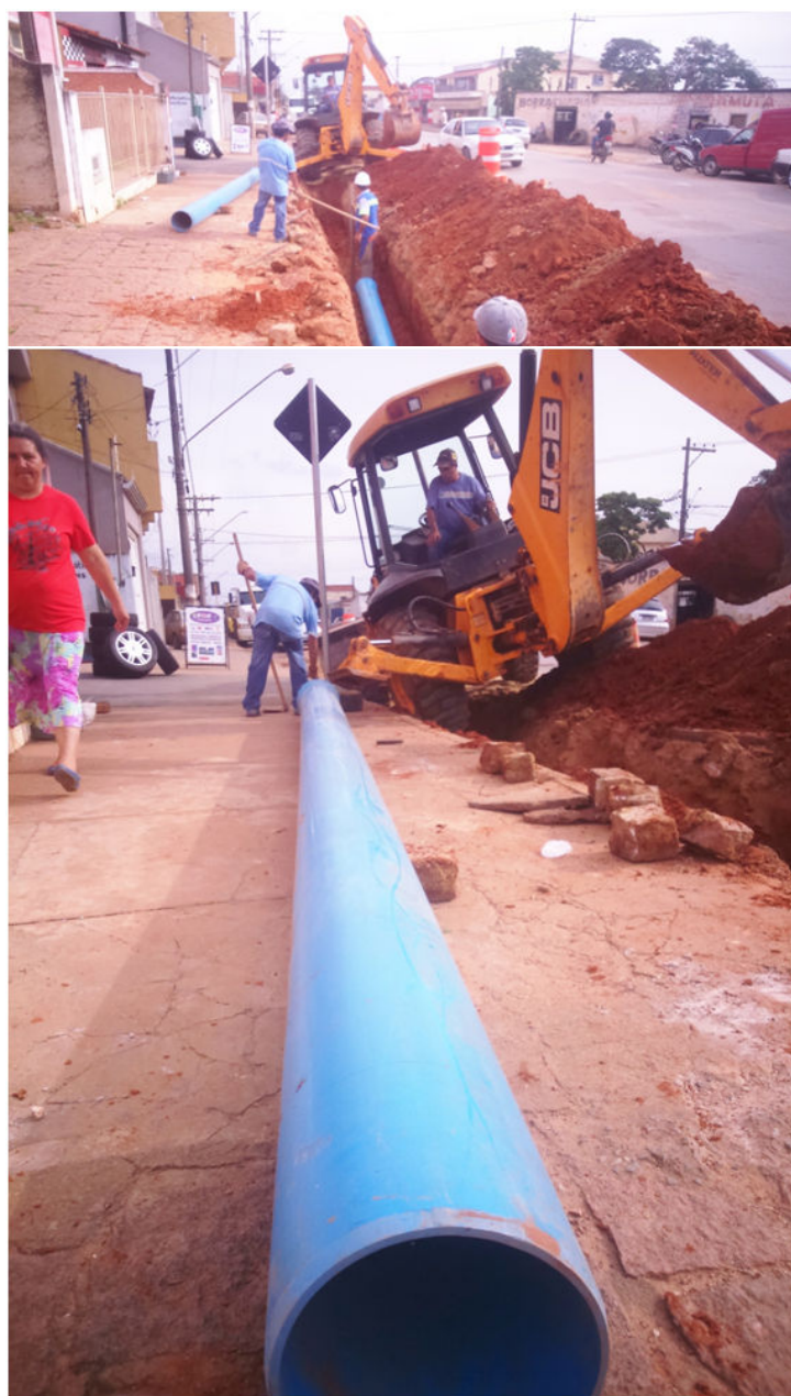
Obras às margens da avenida Plácido Baptista da Silveira
