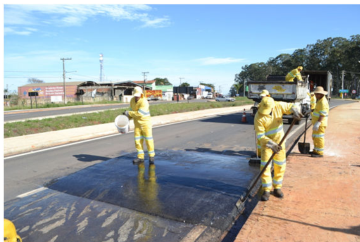
Obras de sinalização e implantação de redutores de velocidade no trecho duplicado
