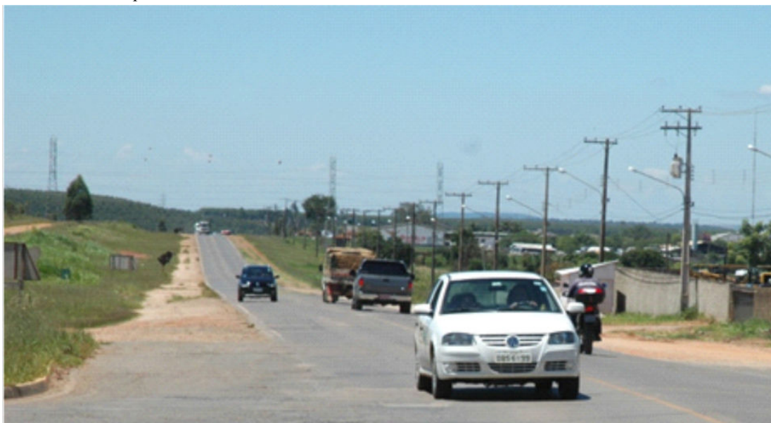
Obras de duplicação devem começar ainda este ano
