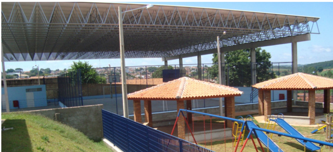
Obras praticamente concluídas: inauguração acontecerá no dia 07 de dezembro
