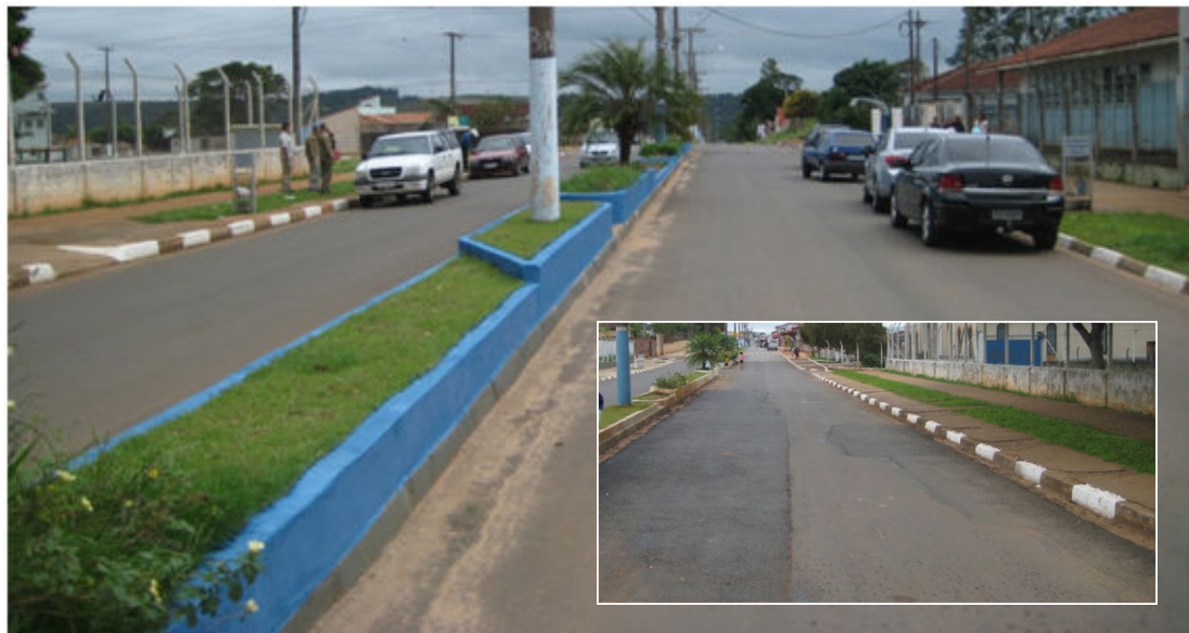
Trecho recuperado e canteiros pintados na avenida
