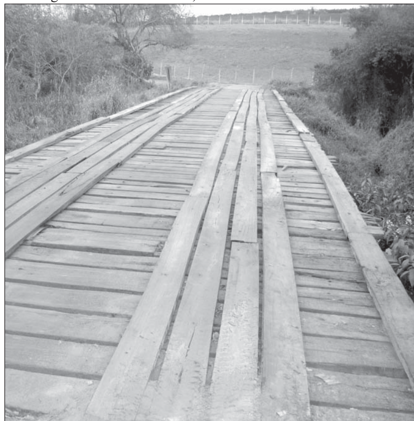
Ponte recuperada através de parceria entre as prefeituras de Capão Bonito e São Miguel Arcanjo
