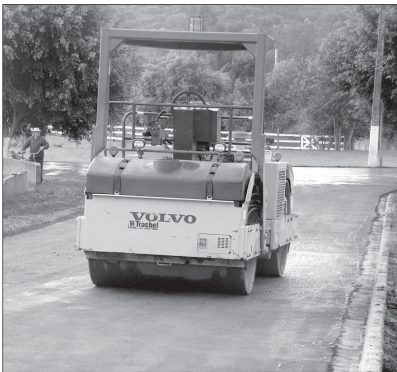
Pavimentação no Distrito do Turvo dos Almeidas
