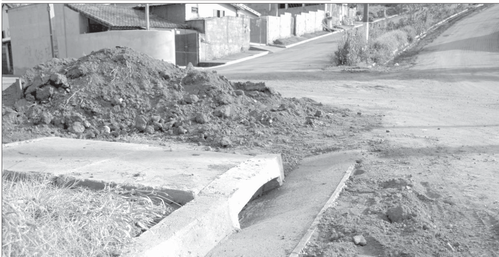
Galerias para escoamento de águas pluviais construídas na Avenida Cerejeiras
