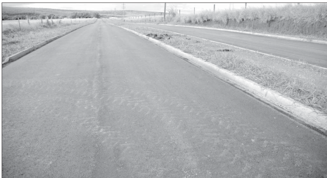
Avenida de acesso ao Bairro Boa Esperança asfaltada
