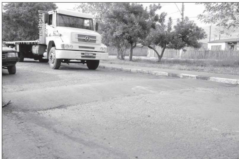
Avenida João Antunes Rodrigues com redutor de velocidade
