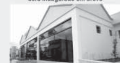
Reforma do Pronto Socorro concluída em 2009
