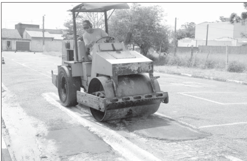
Operação tapa-buracos em ruas da Nova Capão Bonito
