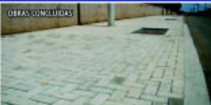
Calçada na Escola Municipal Maria da Conceição Lucas Meidazis
