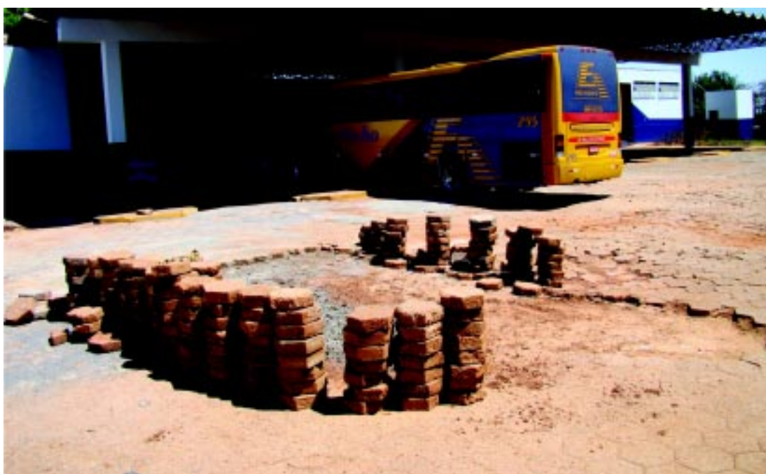
Recuperação do pavimento do Terminal Rodoviário
