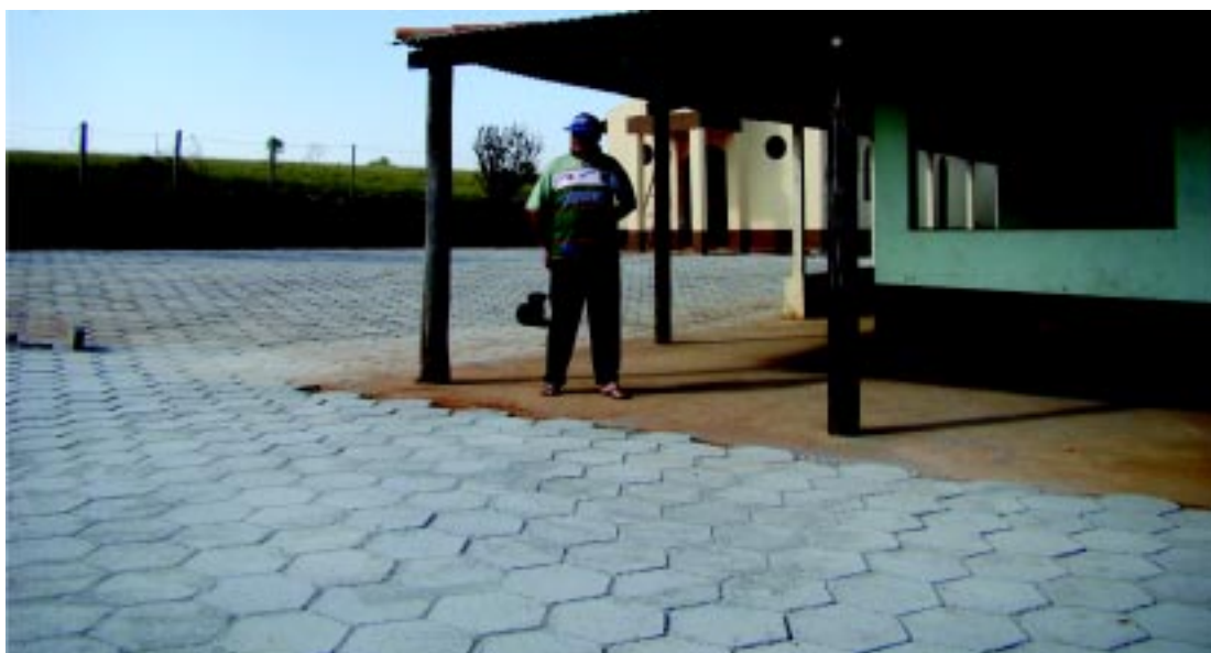
Bairro Baguaçu: lajotamento está sendo concluído
