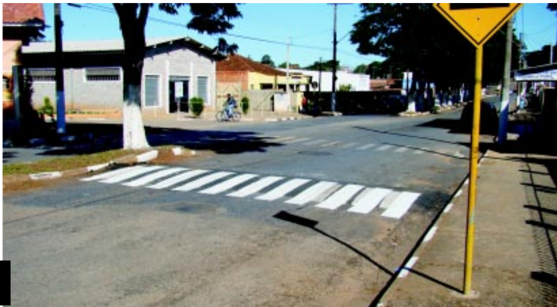
Lombada em frente ao Centro de Assistência Social Pe. Henrique
