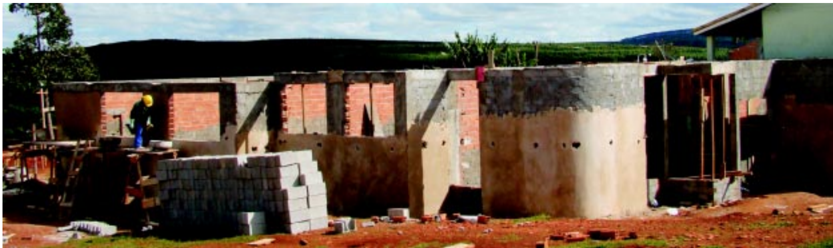
Futuras instalações do Centro de Atenção à Mulher no Jardim Vale Verde
