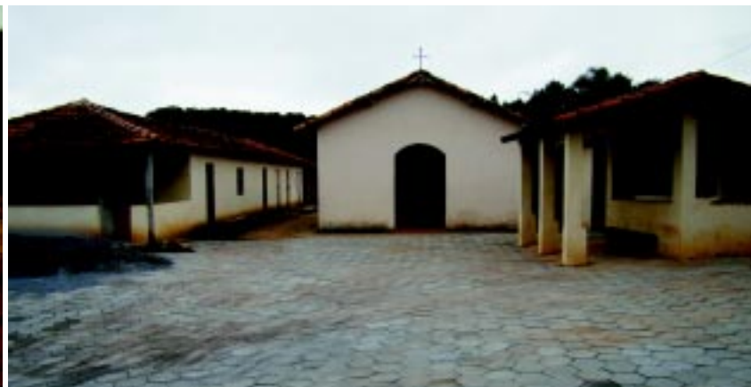
Depois – com o lajotamento concluído no Sítio Velho
