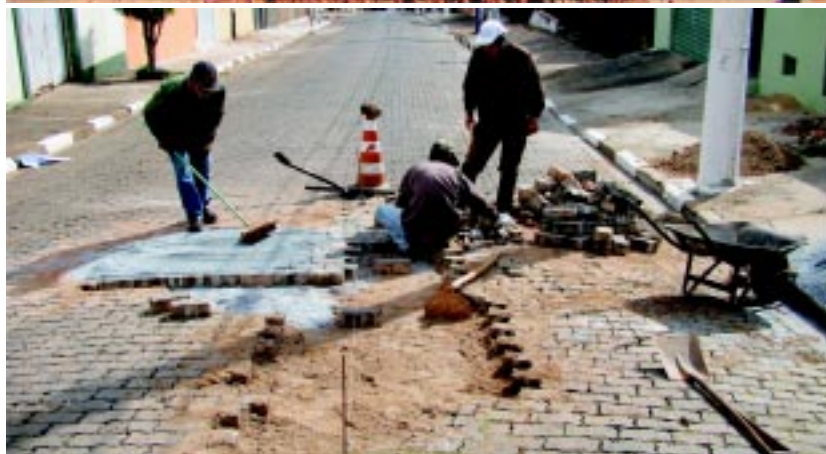
Serviços em calçadas e rua da vila Santa Rosa
