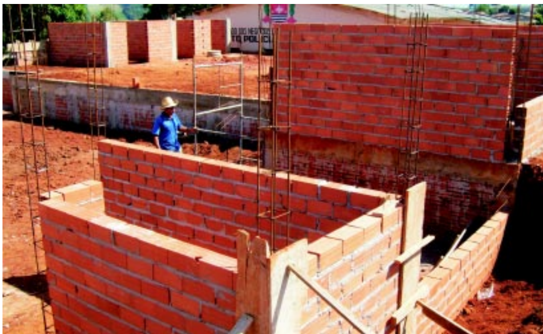
Obras da Nova UBS estão em estágio avançado
