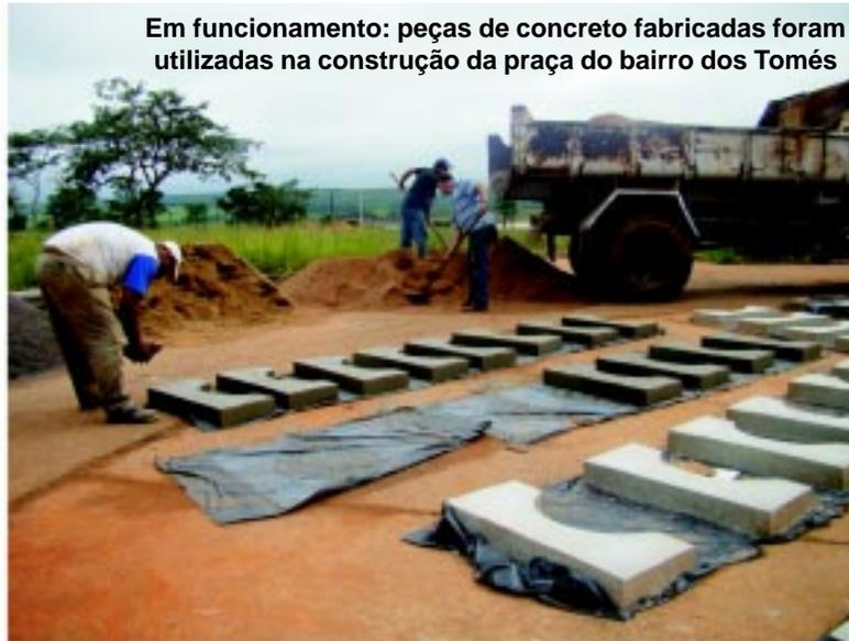
Em funcionamento: peças de concreto fabricadas foram utilizadas na construção da praça do bairro dos Tomés
