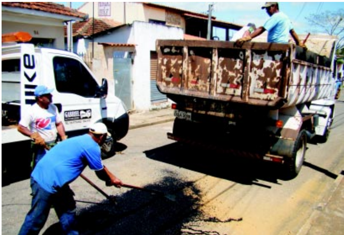
Funcionários da prefeitura trabalhando em operação tapa buracos no ano passado: neste ano foram compradas 450 toneladas de asfalto
