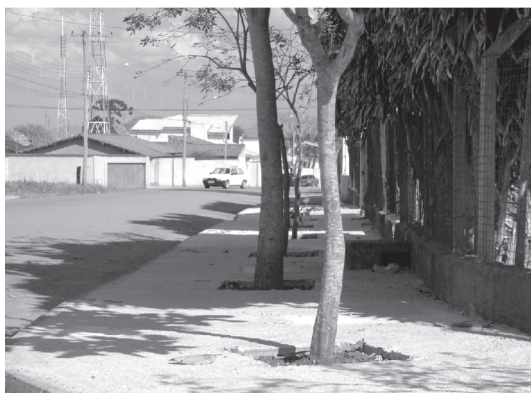
Depois com a calçada já construída
