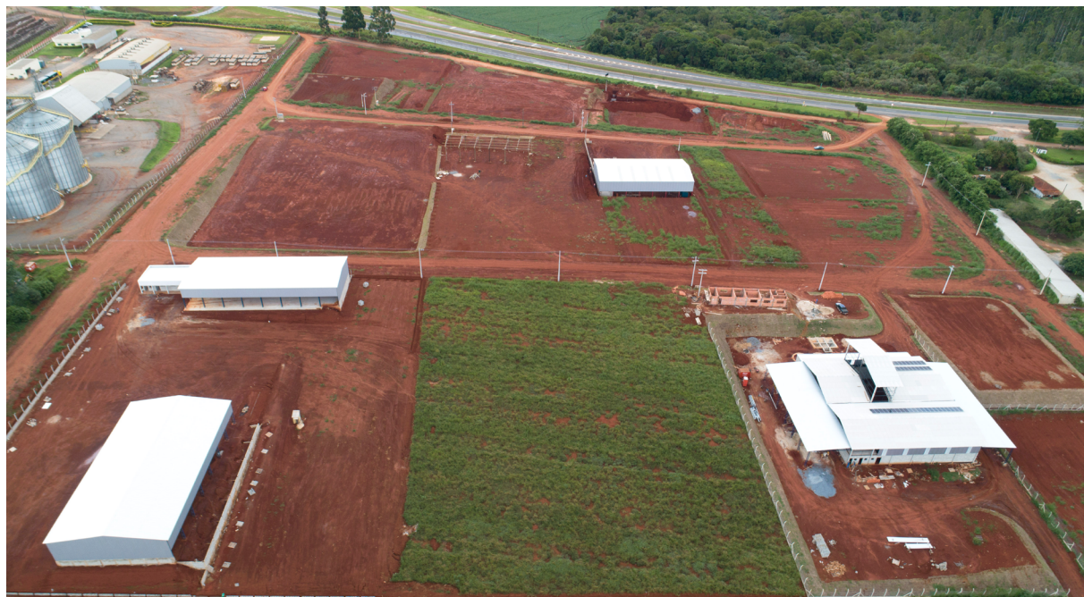
Ruas do Distrito Industrial II serão pavimentadas por meio do investimento da Prefeitura
